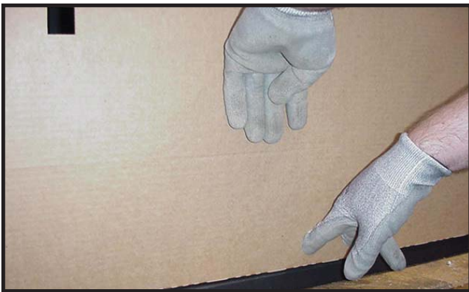
Figure 13.7 Préparation à l'ouverture du panneau d'accès inférieur
