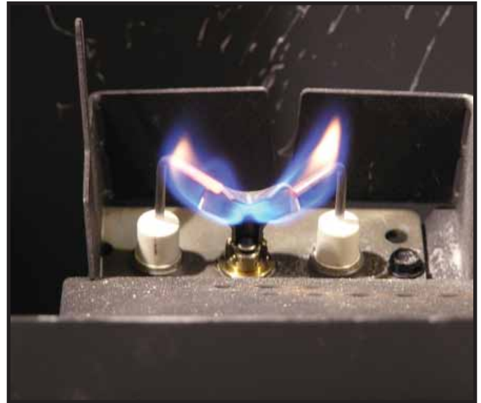
Figura 3.1 Apariencia de las llamas de un piloto IPI
