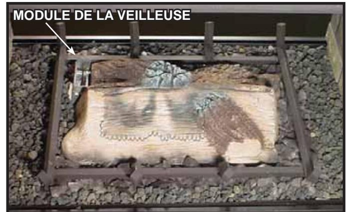
**ÉTAPE 1.** Avant de placer les bûches, consulter le manuel d'installation afin de prendre connaissance des directives sur l'agencement et le positionnement du lit de braises électrique.
