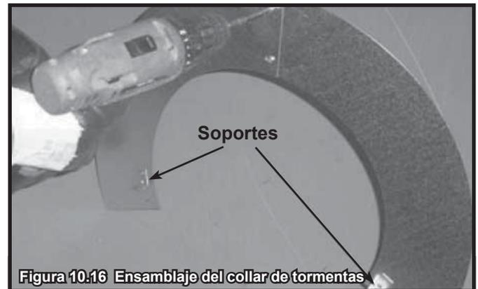
Figura 10.16 Ensamblaje del collar de tormentas
