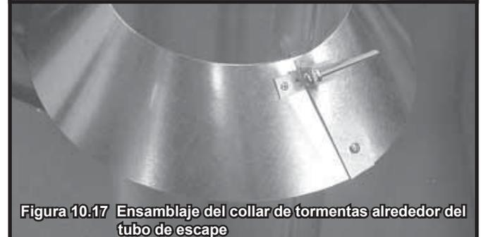
Figura 10.17 Ensamblaje del collar de tormentas alrededor del tubo de escape
