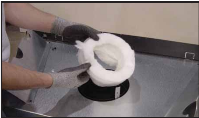
Figura 7.6 Retire el aislamiento que se encuentra dentro del tubo exterior. En el caso de una ventilación trasera el tubo exterior no tiene aislamiento.
