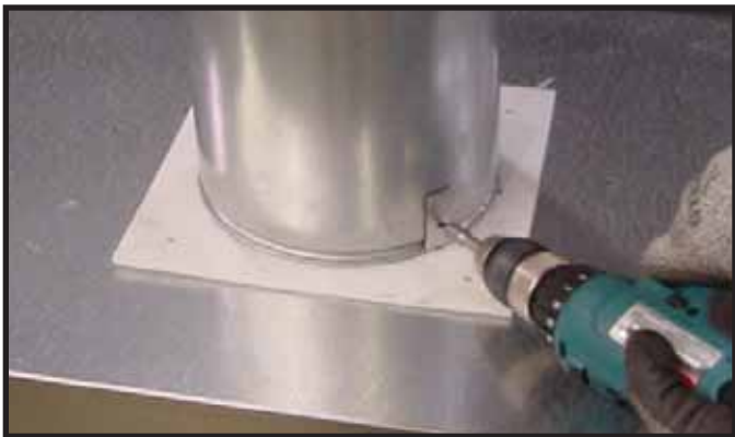
Figura 7.7 Al instalar la primera sección de tubo, asegúrese de eliminar la brecha entre el tubo y el envoltorio exterior de la chimenea usando la empaquetadura de fibra de vidrio que se encuentra en la bolsa que contiene el manual. Utilice dos tornillos auto perforadores para asegurar la empaquetadura al envoltorio exterior del aparato.
