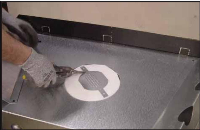
Figura 7.2 Corte la tapa selladora por los rectángulos ubicados a los lados del disco.
