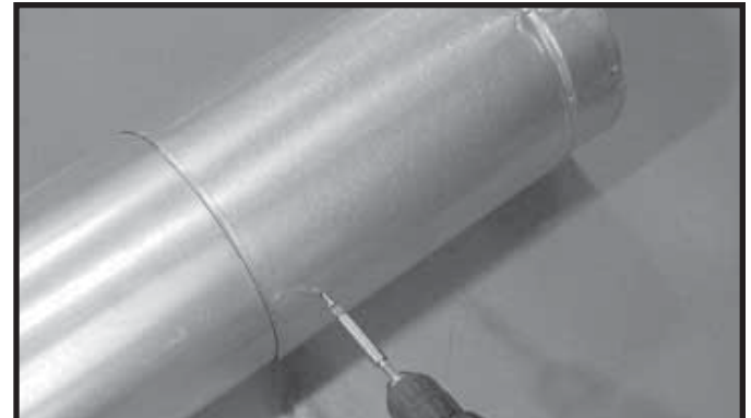
Figura 8.7 Aseguramiento de la sección ajustable
