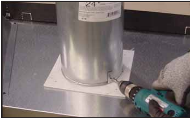
Figure 7.7 Pour attacher la première section du tuyau d'évacuation, assurez-vous d'utiliser le joint en fibre de verre expédié dans la pochette du manuel pour sceller le premier tuyau à l'enveloppe extérieure du foyer. Utilisez 2 vis autotaraudeuses pour attacher le joint à l'enveloppe extérieure.
