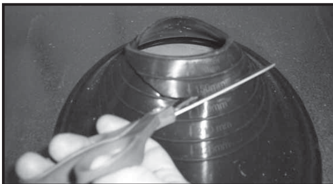
Figure 8.19 Tailler le fourreau protecteur en caoutchouc
