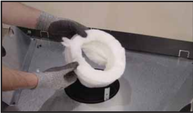
Figure 7.6 Retirez l'isolation du tuyau de conduit extérieur. Dans le cas d'évacuation arrière, il n'y a pas d'isolation dans le tuyau du conduit extérieur.
