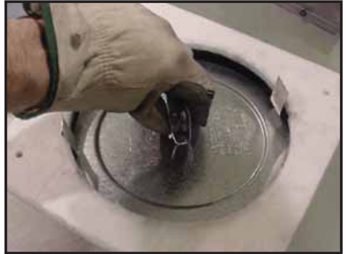
Figure 7.4 Repliez les parties centrales de la bande de retenue vers le haut et utilisez cela pour retirer le chapeau d'évent.
