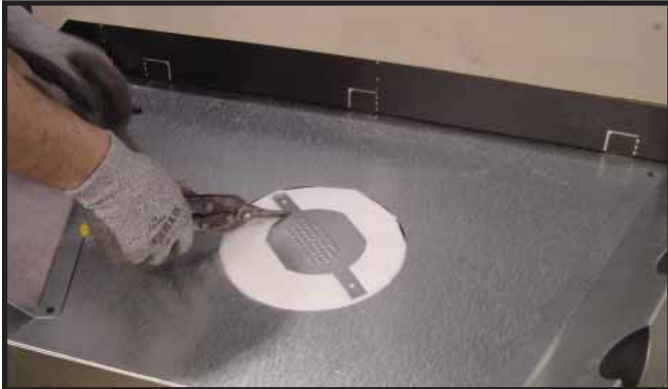
Figura 9.1 Corte la tapa selladora por los rectángulos ubicados a los lados del disco.
