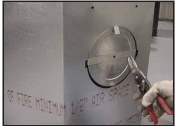
Figura 9.8 Corte la banda de retención y doble los lados hacia afuera.
