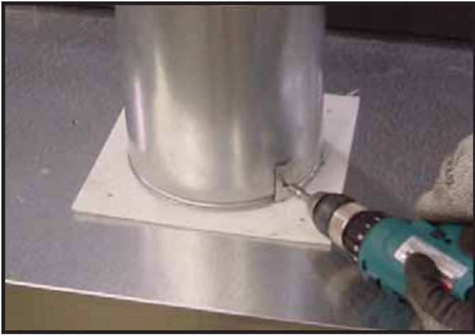
Figura 9.6 Al instalar la primera sección de tubo, asegúrese de eliminar la brecha entre el tubo y el envoltorio exterior de la chimenea usando la empaquetadura de fibra de vidrio que se encuentra en la bolsa que contiene el manual. Utilice dos tornillos autoperforadores para asegurar la empaquetadura al envoltorio exterior del aparato.
