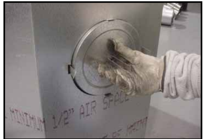
Figure 9.9 Repliez les parties centrales de la bande de retenue vers l'extérieur et utilisez cela pour retirer le capuchon plombé.
