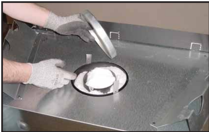
Figure 9.3 Retirez le capuchon plombé.
