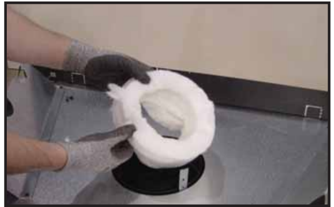
Figure 9.5 Retirez l'isolation du tuyau de conduit extérieur. Dans le cas d'évacuation arrière, il n'y a pas d'isolation dans le tuyau du conduit extérieur.
