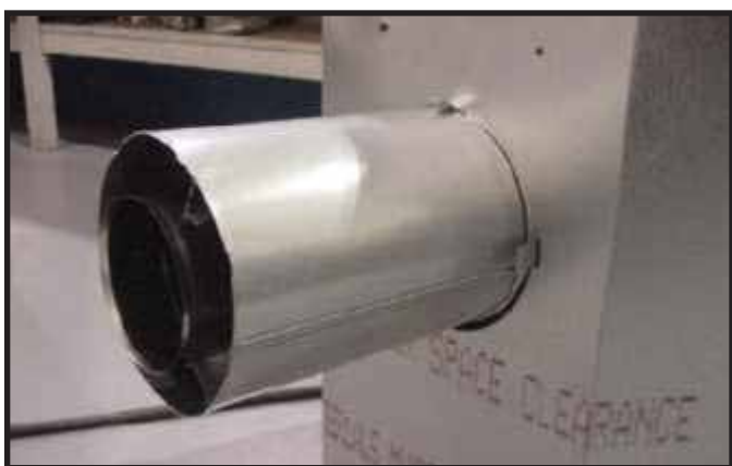
Figura 9.11 Instale la primera sección del tubo de escape (ésta se calzará en su lugar). Deslice la empaquetadura en la sección del tubo de escape y sobre las lengüetas hasta que toque la chimenea.
