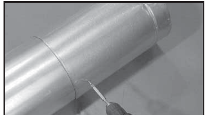
Figura 10.7 Aseguramiento de la sección ajustable
