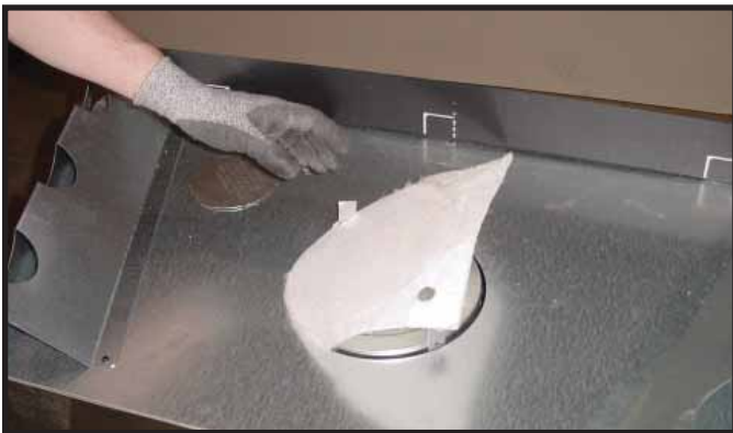
Figura 9.2 Retire la empaquetadura blanca que cubre la tapa selladora.
