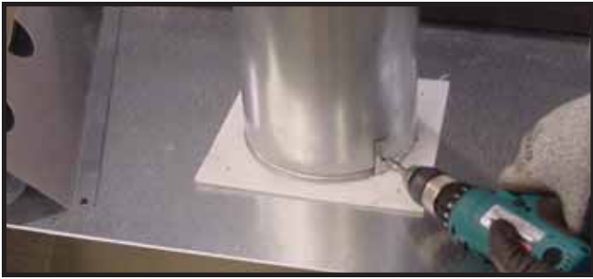
Figure 9.7 Pour attacher la première section du tuyau d'évacuation, assurez-vous d'utiliser le joint en fibre de verre expédié dans la pochette du manuel pour sceller le premier tuyau à l'enveloppe extérieure du foyer. Utilisez 2 vis autotaraudeuses pour attacher le joint à l'enveloppe extérieure.
