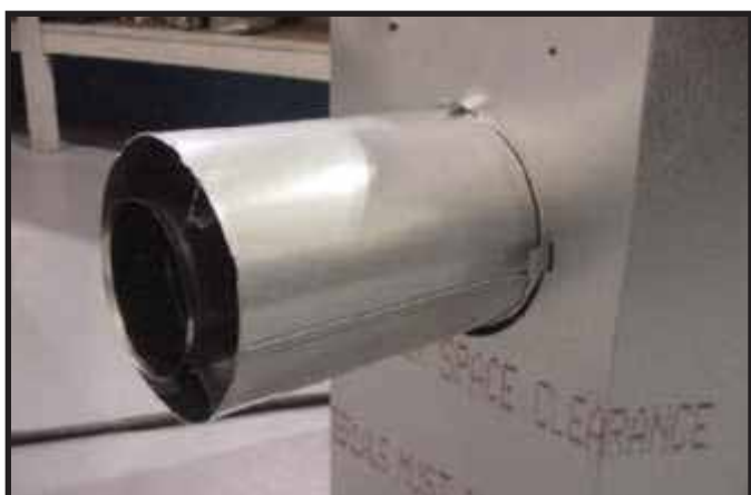
Figure 9.12 Fixez la première section d'évent (en s'encliquettera en place). Glissez le joint d'étanchéité d'isolant sur la section d'évent, contre le foyer et sur les pattes.
