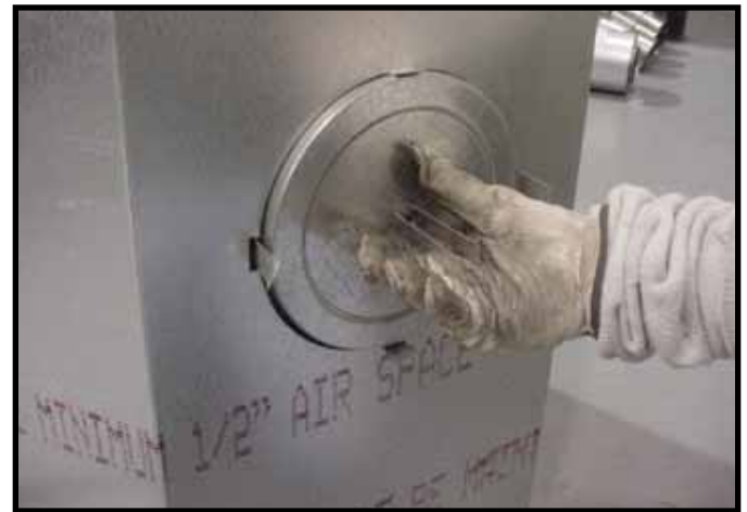
Figure 9.10 Repliez les parties centrales de la bande de retenue vers l'extérieur et utilisez cela pour retirer le capuchon plombé.
