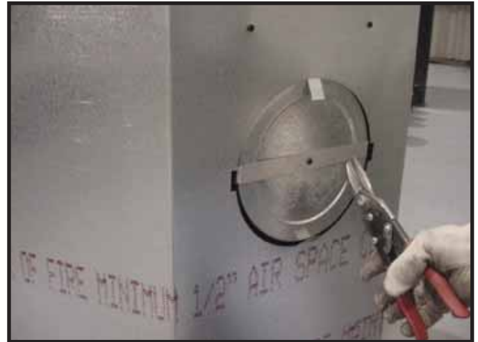
Figure 9.9 Coupez la bande de retenue de métal et repliez les côtés vers l'extérieur.
