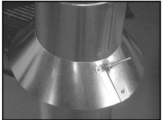
Figure 8.19 Installation de la mitre sur le conduit
