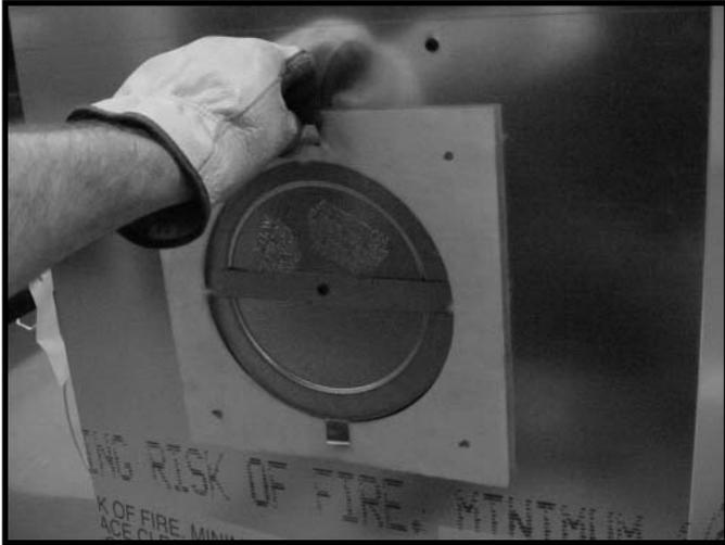
**Figure 7.6** Plier les pattes vers le centre du tampon pare-feu (90°) et enlever le joint d'isolation.
