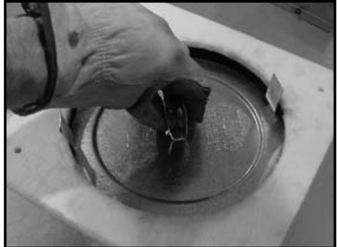
**Figure 7.4** Replier les parties centrales de la bande de rétention vers le haut et les utiliser pour enlever le couvercle du conduit d'évacuation.
