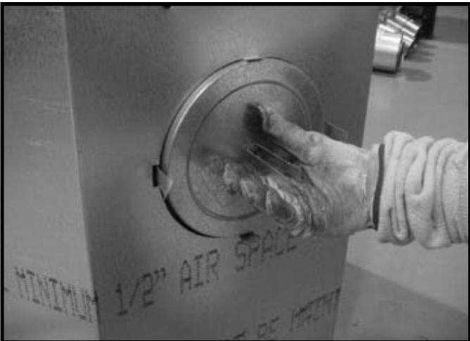
**Figure 7.8** Replier les parties centrales de la bande de rétention vers l'extérieur et les utiliser pour enlever le couvercle du conduit d'évacuation.
