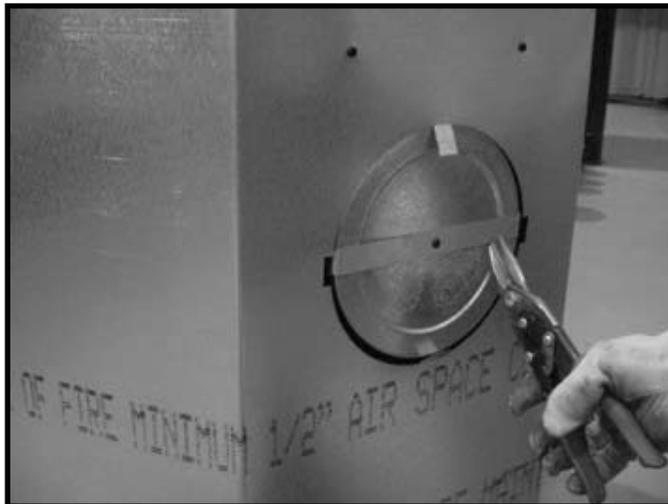
**Figure 7.7** Couper la bande métallique de rétention et plier les deux parties coupées vers l'extérieur.
