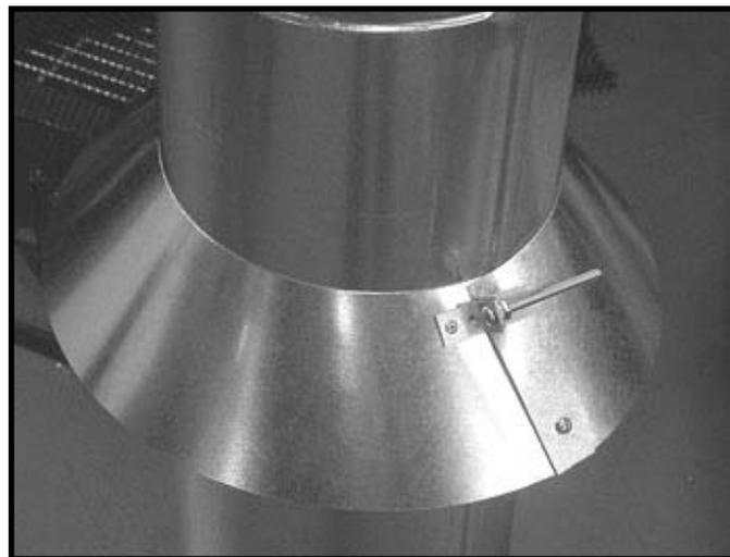
Figure 8.17 Pose de la mitre autour du tuyau
