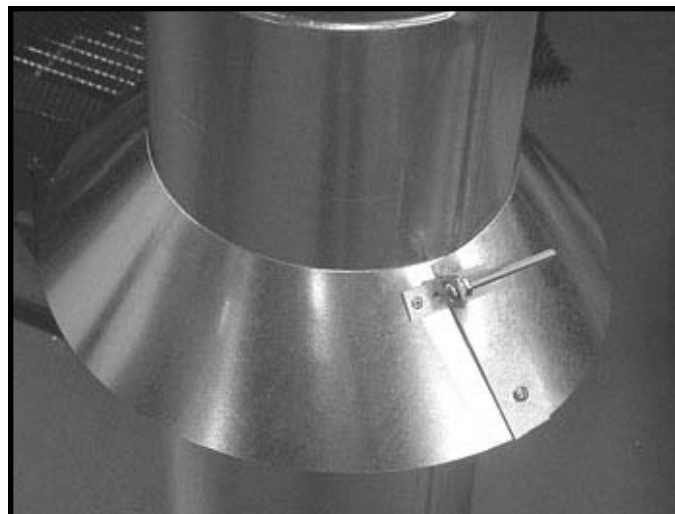
Figure 8.17 Pose de la mitre autour du tuyau
