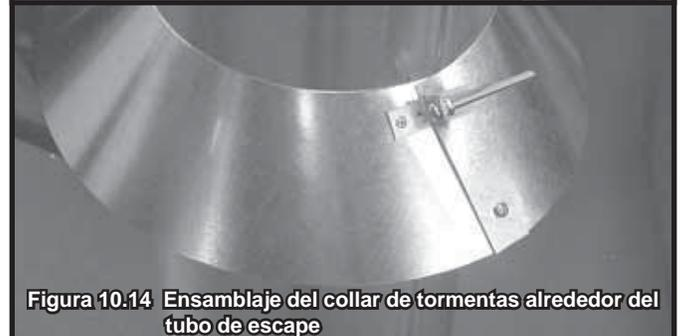
Figura 10.14 Ensamblaje del collar de tormentas alrededor del tubo de escape
