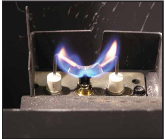
Figure 3.1 Forme de la flamme d'une veilleuse Intellifire
