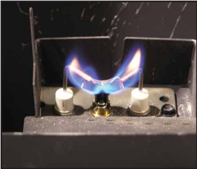
Figure 3.1 Forme de la flamme d'une veilleuse Intellifire
