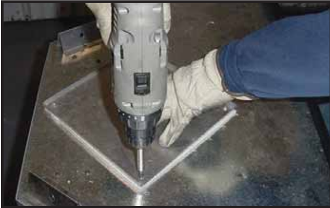
Figura 9.1 Retire los 4 tornillos que sostienen la placa protectora a la parte de arriba de la chimenea y deséchela.
