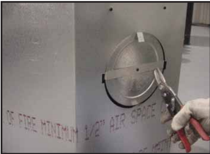
Figura 9.7 Corte la banda de retención y doble los lados hacia afuera.
