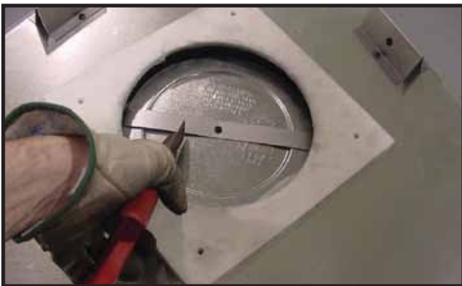
Figura 9.3 Corte la banda retenedora y doble los lados hacia afuera.
