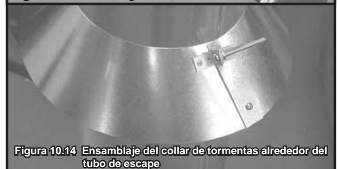
Figura 10.13 Ensamblaje del collar de tormentas
