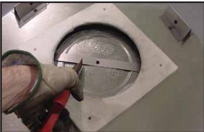
Figure 9.3 Coupez la bande de retenue de métal et repliez les côtés vers l'extérieur.
