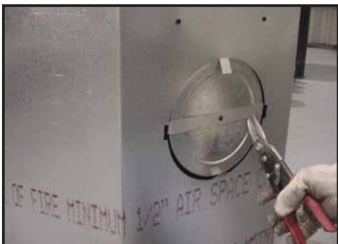
Figure 9.7 Coupez la bande de retenue de métal et repliez les côtés vers l'extérieur.
