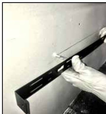
Figure 4.5 Installation des ancrages dans un mur creux
