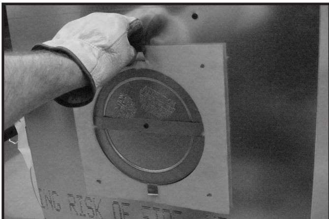
**Figure 6.12 (foyer générique illustré)** Pliez les languettes vers le centre du branchement au feu (90°) puis enlevez le joint d'isolant.
