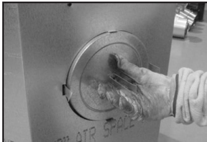
**Figure 6.14 (représentation d'un foyer générique)** Repliez vers l'extérieur les parties centrales de la bande de retenue et les utiliser pour enlever le couvercle du conduit.
