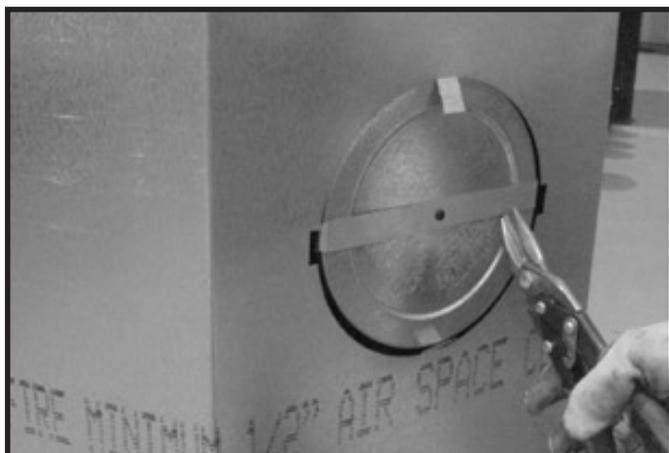
**Figure 6.13 (représentation d'un foyer générique)** Coupez la bande métallique de retenue et pliez les deux parties coupées vers l'extérieur.
