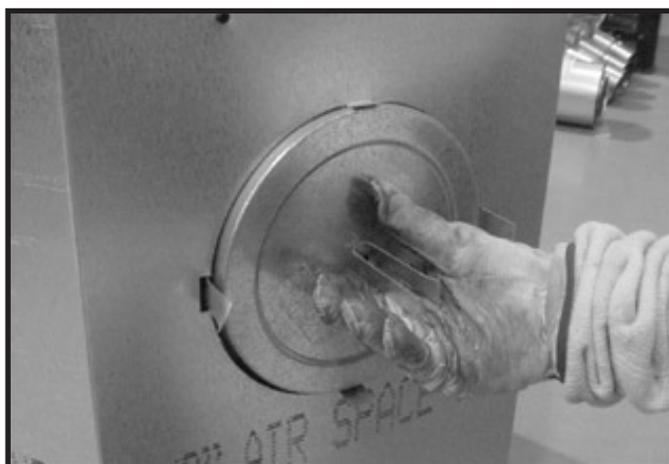
**Figure 6.14 (représentation d'un foyer générique)** Repliez vers l'extérieur les parties centrales de la bande de retenue et utilisez-les pour enlever le couvercle du conduit.
