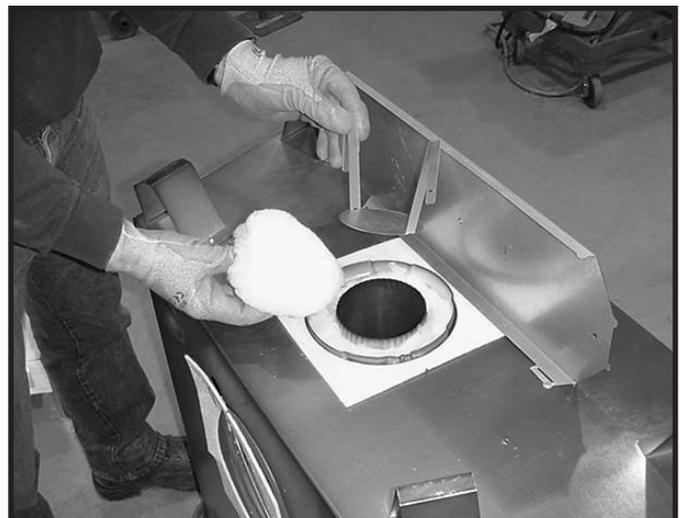
Figure 6.9 Retirez le panier d'isolation et l'isolant blanc du centre du conduit d'évacuation des gaz.
