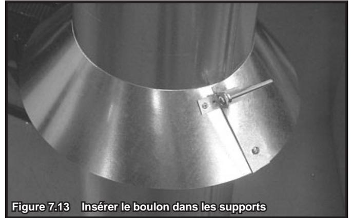
Figure 7.13 Insérer le boulon dans les supports
