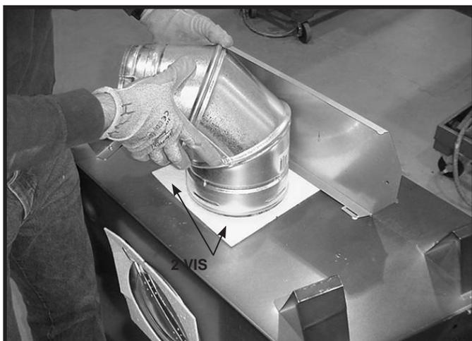
**Figure 6.11** Pour fixer la première section du conduit d'évacuation, assurez-vous d'utiliser le joint d'étanchéité en fibre de verre pour sceller entre le premier composant et l'enveloppe extérieure du foyer. Utilisez 2 vis autotaraudeuses pour fixer le joint d'étanchéité à l'enveloppe extérieure.
