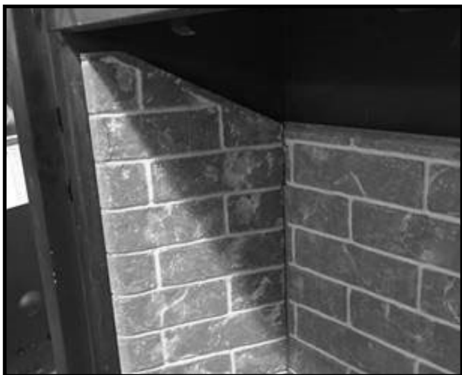
Figure 11.3 Installation du panneau réfractaire gauche
