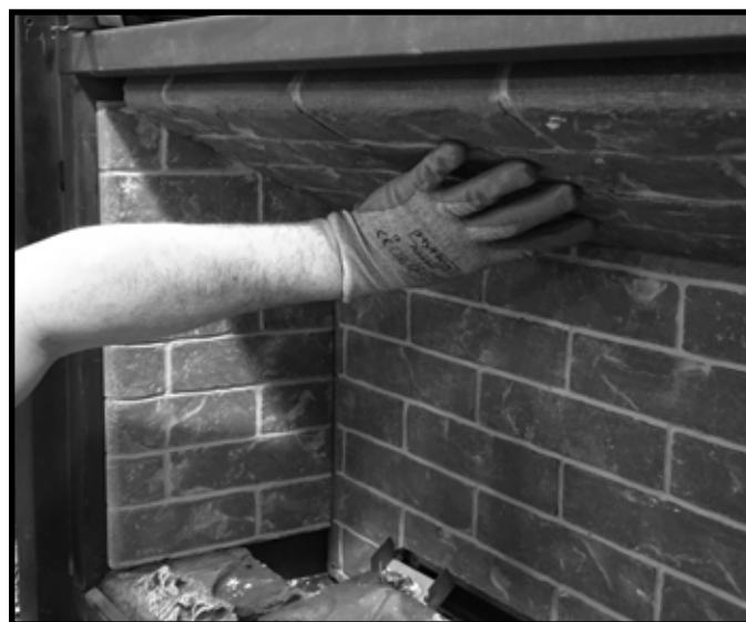
Figure 11.5 Installation du panneau réfractaire droit
