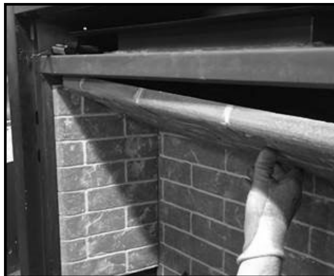
Figure 11.4 Installation du panneau réfractaire supérieur
