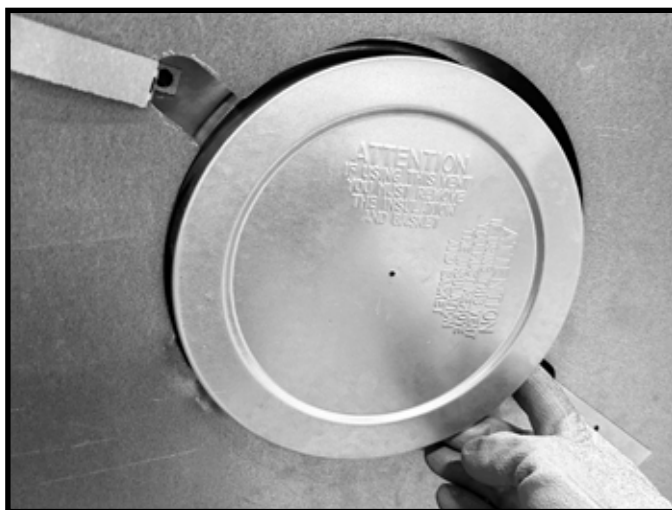
Figure 6.10 Replier les sangles à l'écart du bouchon. Retirer le capuchon d'étanchéité en utilisant les découpes.
