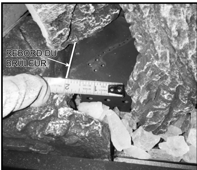
Figure 8 Placer la bûche supérieure gauche
