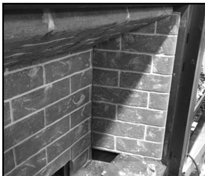
Figure 11.6 Panneau du réfractaire droit installé
