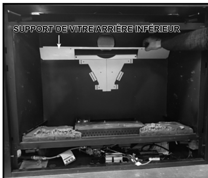
Figure 11.8 Retrait du support de vitre arrière inférieur
