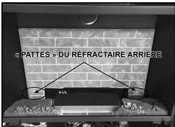
Figure 11.2 Installer la pièce réfractaire arrière
