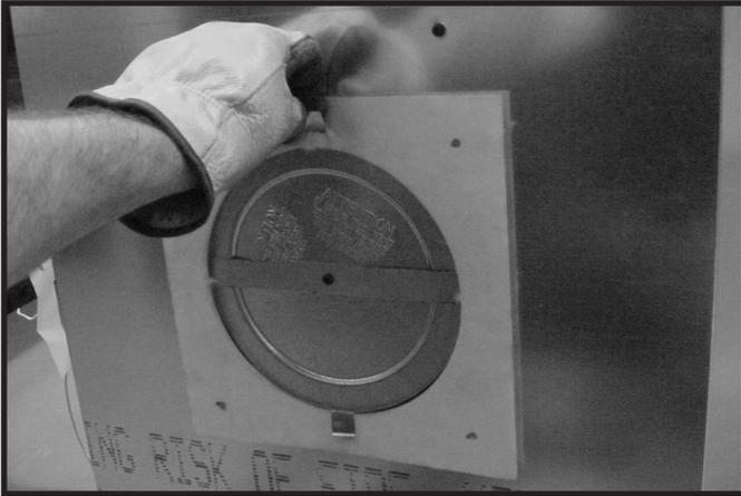
**Figure 6.12 (Foyer générique illustré)** Pliez vers le centre les languettes du bouchon coupe-feu (90 °) et retirez le joint d'étanchéité.
