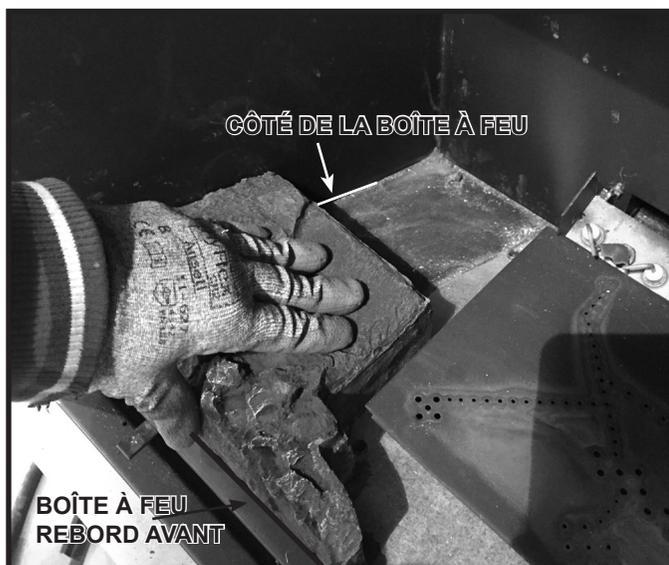
Figure 11.2 Installer le composant de l'âtre de gauche
