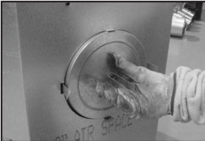
**Figure 6.14 (foyer générique illustré)** Repliez vers l'extérieur les parties centrales de la bande de retenue et les utiliser pour enlever le couvercle du conduit.
