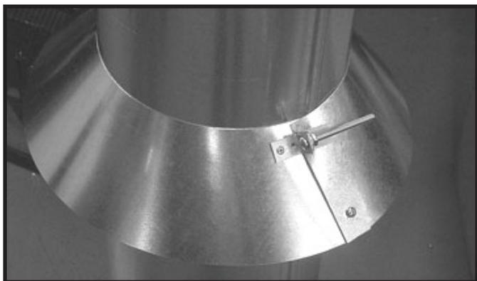
Figure 7.13 Insérer le boulon dans les supports
