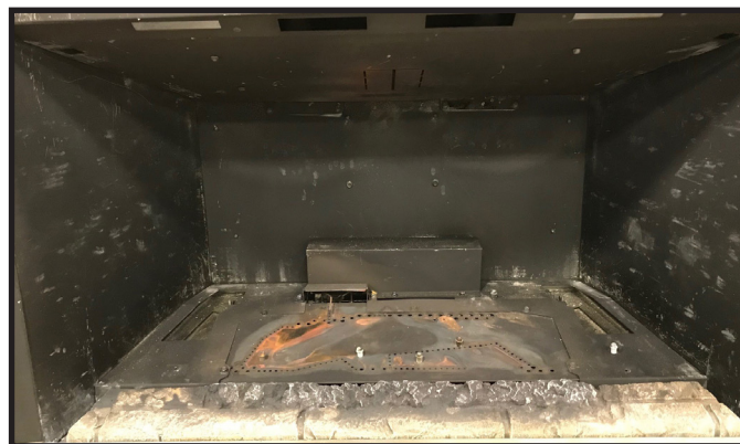
Figure 3 Réfractaire de base installé
