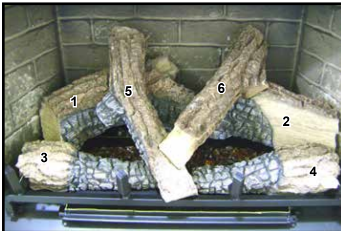
Figure 1. Série de bûches installée
