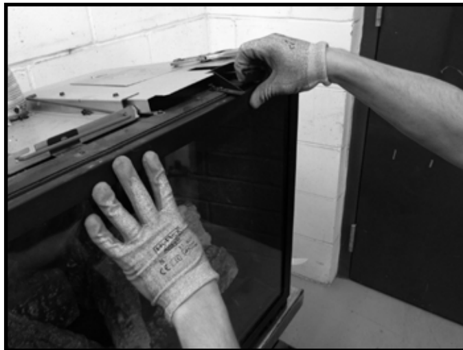
Figure 11.3 Dégager les verrous de la vitre un à la fois
