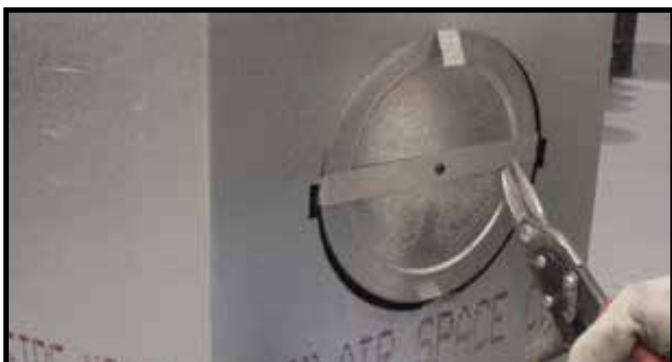
Figure 6.8 Coupez la bande métallique de retenue et pliez les deux parties coupées vers l'extérieur.
