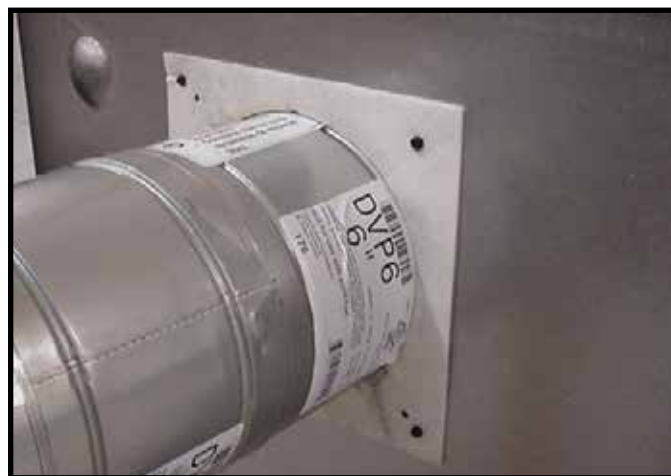
Figure 6.11 Posez la première section du conduit d'évacuation (elle se met en place en provoquant un clic). Glissez le joint d'isolation sur cette section du conduit, contre le poêle, en passant sur les languettes. Utilisez les quatre vis autotaraudeuses pour fixer le joint à l'enveloppe extérieure.
