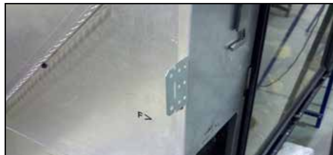
Figure 6.4 Languette à clouer pliée vers l'extérieur pour l'installation
