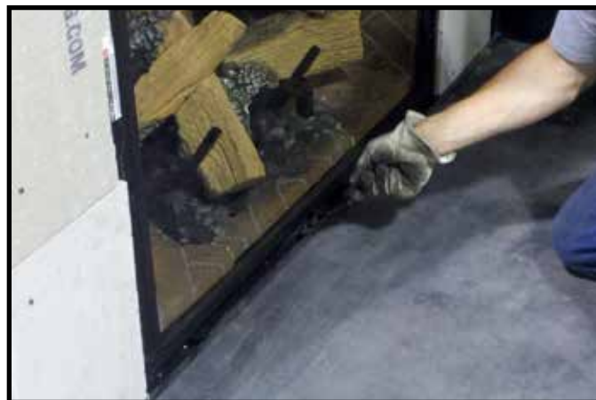
Figure 11.8. Sécuriser les clips de vitre inférieurs
