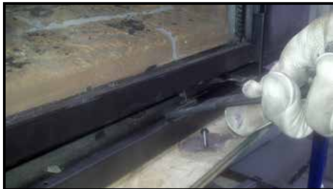
Figure 11.2 Emplacement de l'outil du clip de vitre
