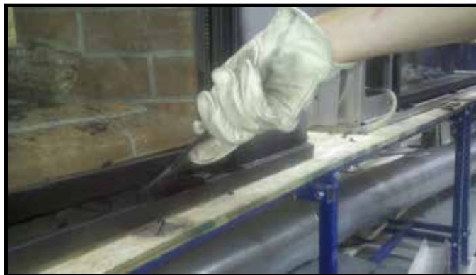
Figure 11.3. Insérer l'outil du clip de vitre
