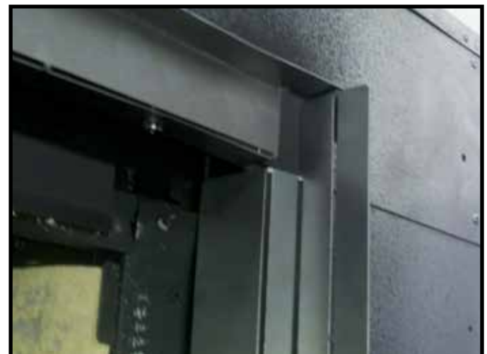
Figure 10.4 Modèles de finition latéral et du dessus installés
