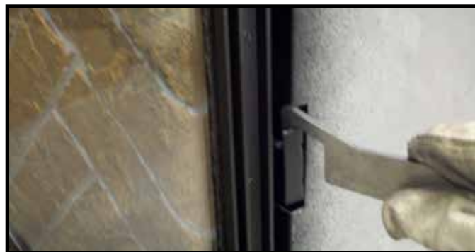
Figure 11.7. Sécuriser les clips de vitre latéraux
