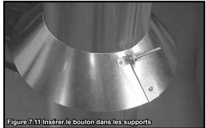
**Figure 7.11** Insérer le boulon dans les supports
