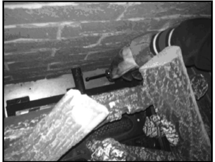
Figure 1. Emplacement de l'obturateur d'air
