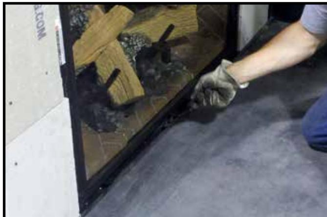
Figure 11.8. Sécuriser les clips de verre inférieurs
