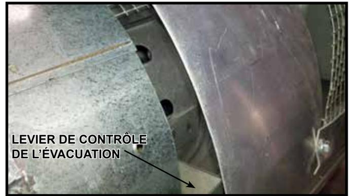
Figure 4.12 Ajustement du levier de contrôle PVK-80 – Ouvert
