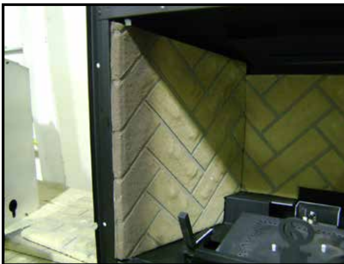
Figure 3. Installation de la brique réfractaire latérale
