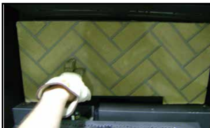
Figure 2. Installer la brique réfractaire arrière
