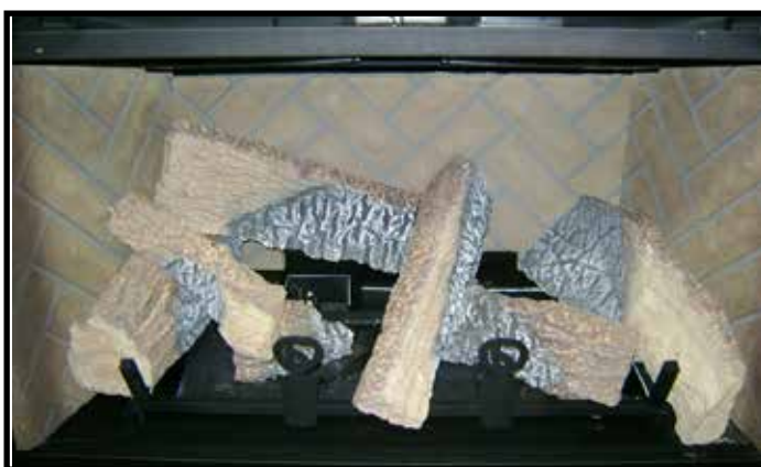
Figure 1. Brique réfractaire et bûches installées
