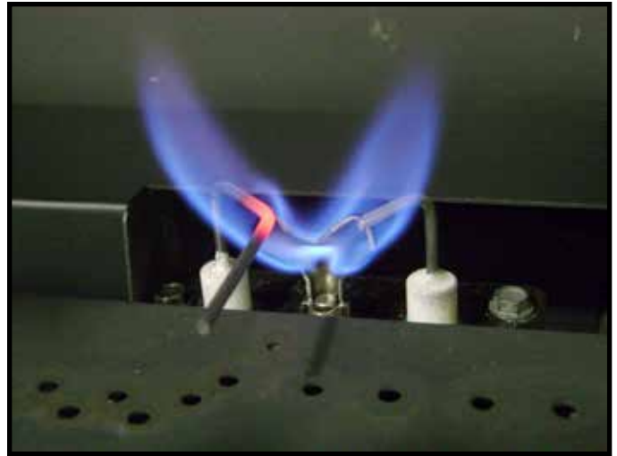
Figure 3.1 Modèles de flamme de la veilleuse IPI
