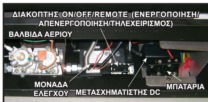
Εικόνα 11.1 Τμήματα βαλβίδας
