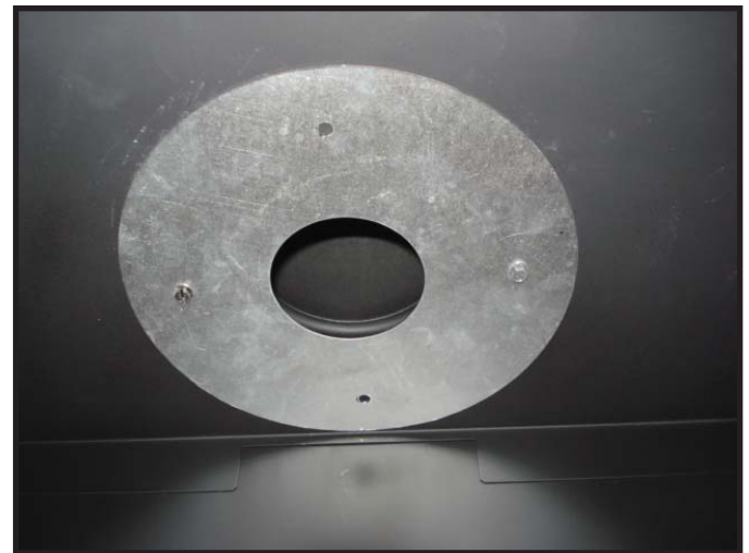
Εικόνα 7.7 Τοποθέτηση μειωτήρα καπναερίων
