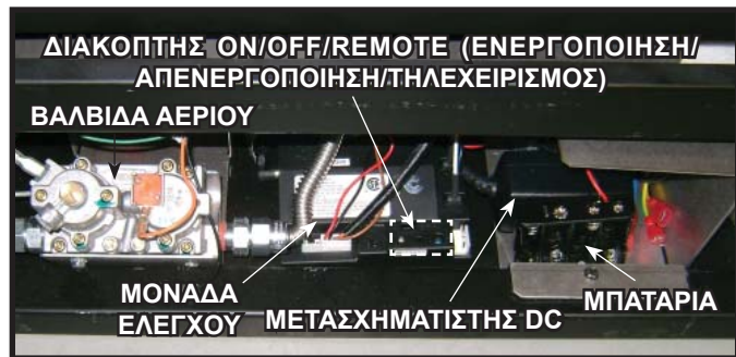
Εικόνα 16.2 Τμήματα βαλβίδας
