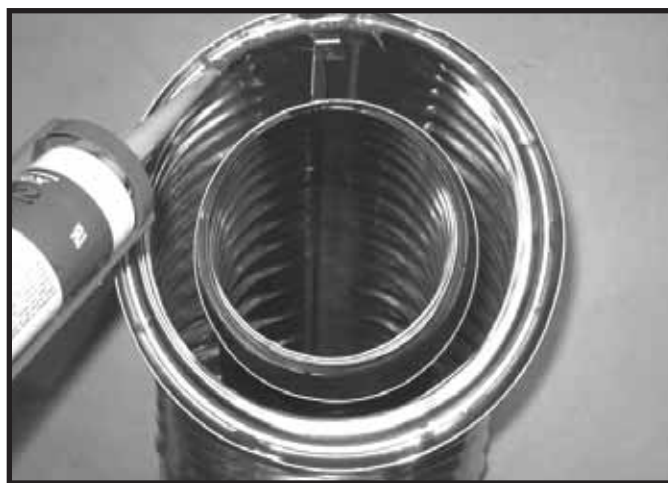
Obr. 10.2 Silikónové tesnenie odolné voči vysokým teplotám
