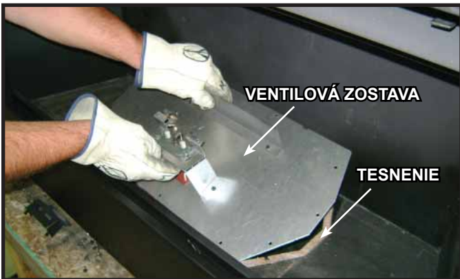
Obr. 16.6 Demontáž ventilovej dosky
