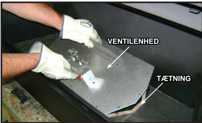
Figur 16.6 Fjernelse af ventilpladen
