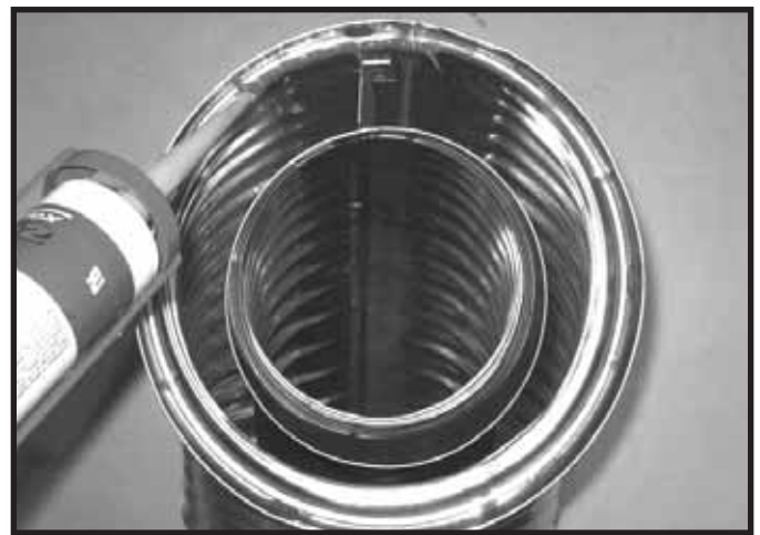
Figur 10.2 Forsegling med varmeresistent silikone
