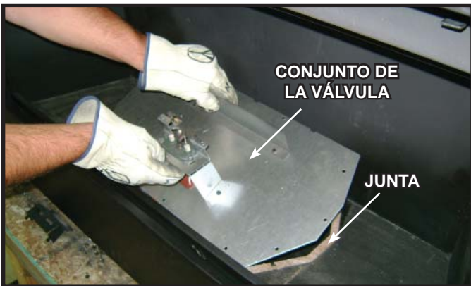
Figura 16.6 Retire el conjunto de la válvula
