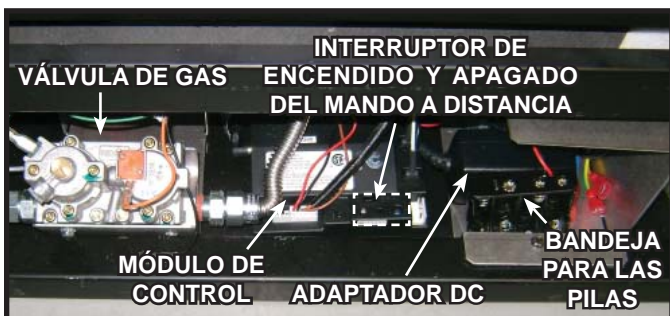
Figura 16.2 Componentes de la válvula de gas
