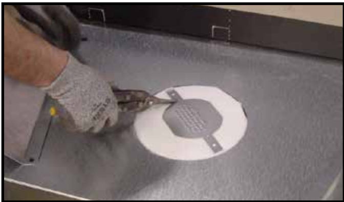
Figure 9.1 Coupez l'attache du capuchon plombé sur les rectangles de deux côtés du disque.
