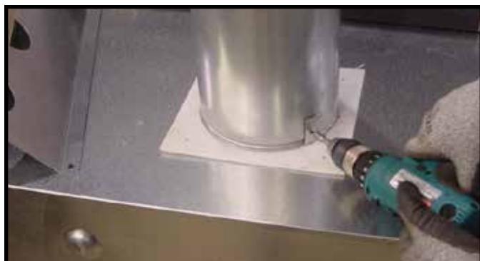
Figure 9.6 Pour attacher la première section du tuyau d'évacuation, assurez-vous d'utiliser le joint en fibre de verre expédié dans la pochette du manuel pour sceller le premier tuyau à l'enveloppe extérieure du foyer. Utilisez 2 vis autotaraudeuses pour attacher le joint à l'enveloppe extérieure. Un mastic d'un indice d'exposition continue d'un minimum de 300° F.
