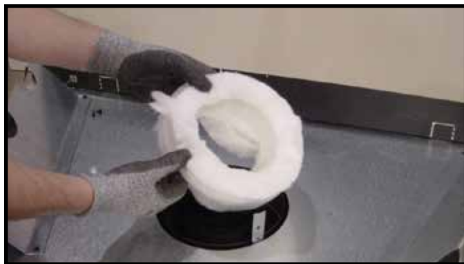
Figure 9.5 Retirez l'isolation du tuyau de conduit extérieur. Dans le cas d'évacuation arrière, il n'y a pas d'isolation dans le tuyau du conduit extérieur.
