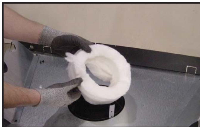
Figure 9.5 Retirez l'isolation du tuyau de conduit extérieur. Dans le cas d'évacuation arrière, il n'y a pas d'isolation dans le tuyau du conduit extérieur.
