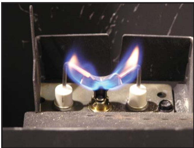
Figure 3.1 Forme de la flamme d'une veilleuse IPI
