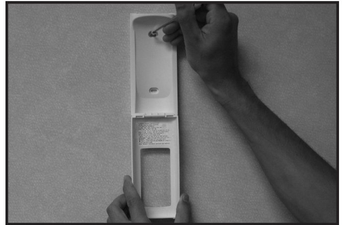
Figura 12.6 Instalación del portamandos
