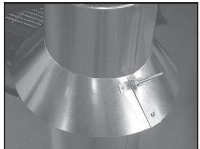
Figura 8.7 Ensamblaje del collarín para lluvias alrededor del conducto de humos
