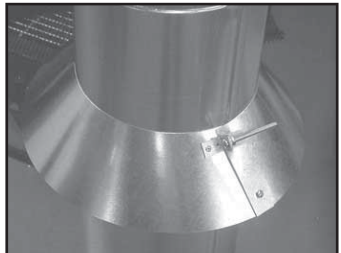
Abbildung 8.7 Anbringen des Windschutzes am Rohr
