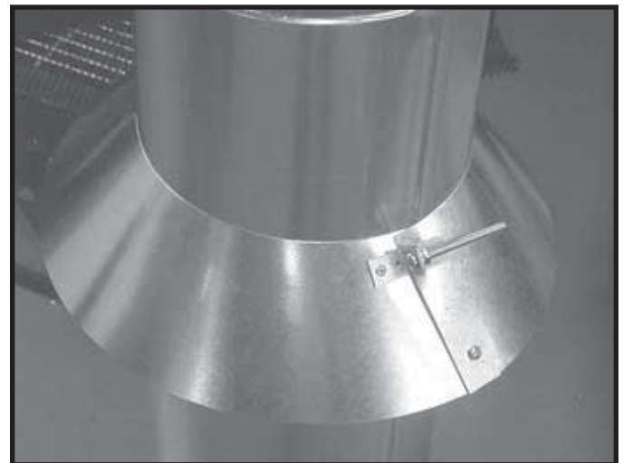
Obr 8.7 Nasadenie strešnej tesniacej manžety okolo rúry
