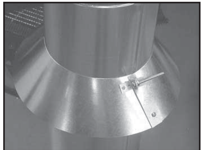
Figur 8.7 Samling af stormkraven omkring røret
