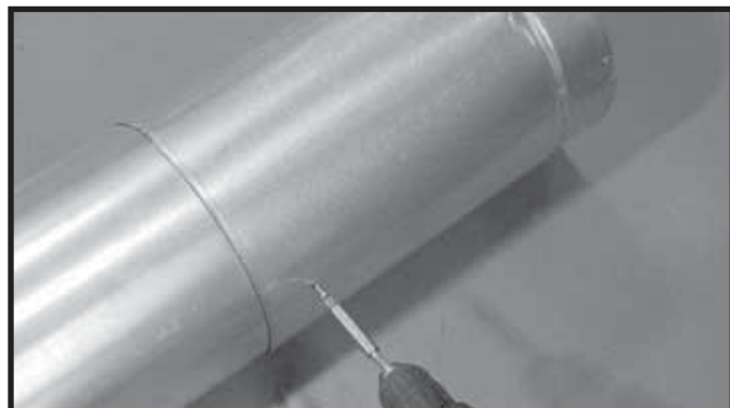
Figur 8.3 Skruer i slipsektionen
