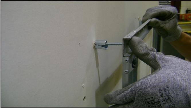
Figure 4.6 Installation des ancrages dans une cloison creuse
