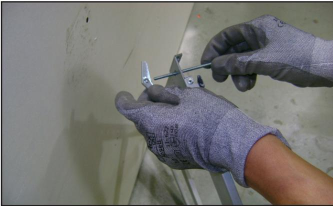
Figure 4.5 Installation des boulons à ailettes dans le support de fixation
