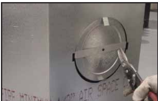
Fig. 9.9 Kutt festebåndene av metall, og bøy sidene utover.
