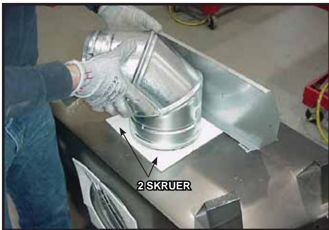
Fig. 9.7 For å feste første seksjon av avtrekksrøret, må du bruke glassfiberpakningen som tetning mellom første ventileringskomponent og utvendig ramme på ildstedet. Bruk 2 selventrende skruer for å feste pakningen til den utvendige rammen.
