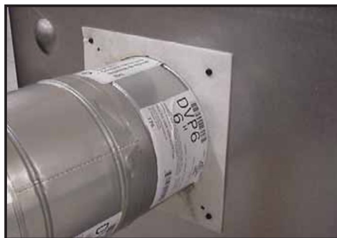
Fig. 9.12 Fest første seksjon av avtrekksrøret (du klikker det på plass). Skyv isolasjonspakningen inn på avtrekksrøret, mot peisen og over maljene. Bruk to selventrende skruer for å feste pakningen til den utvendige rammen.
