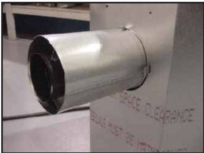
Obr. 9.13. Pripojte prvý úsek dymovodu (tak, aby zapadol na miesto). Nasuňte izolačné tesnenie na tento úsek dymovodu smerom hore proti spotrebiču a cez upevňovacie pliešky.
