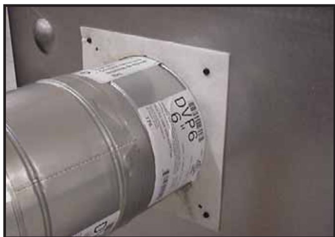
Obr. 9.12. Pripojte prvý úsek dymovodu (tak, aby zapadol na miesto). Nasuňte izolačné tesnenie na tento úsek dymovodu smerom hore proti spotrebiču a cez upevňovacie pliešky. Na uchytenie tesnenia k vonkajšiemu plášťu použijete 2 samorezné skrutky.
