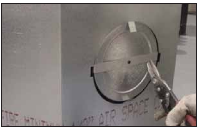
Obr. 9.9. Prerežte prídržný kovový pás a kraje vyhnite smerom von.
