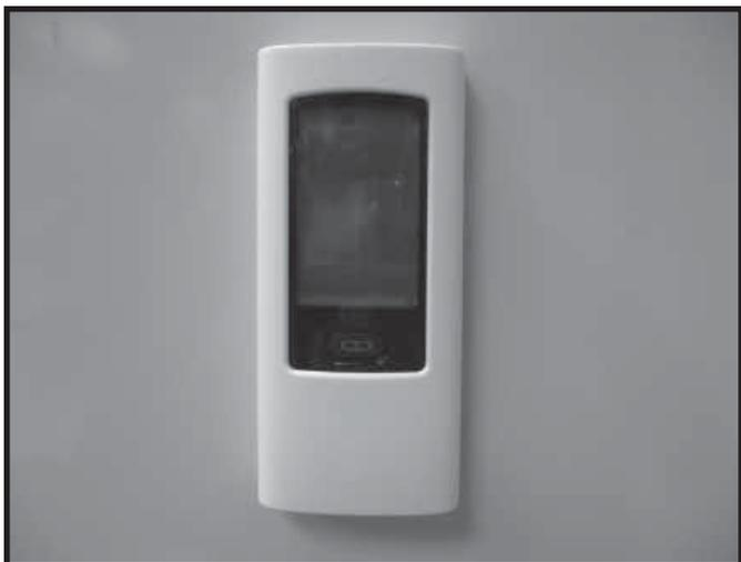
Abbildung 12.8 Montage des Fernbedienungsgehäuses
