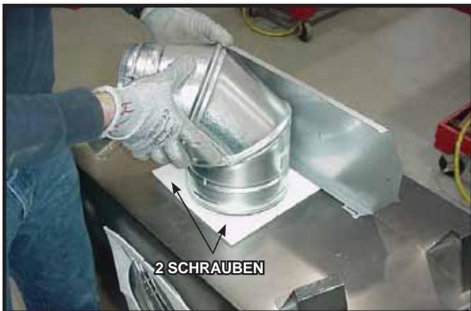
**Abbildung 9.7** Beim Anbringen des ersten Abschnitts des Abzugsrohrs verwenden Sie die Glasfaserdichtung als Versiegelung zwischen der ersten Abzugsrohrkomponente und der Kaminaußenhülle. Verwenden Sie zwei gewindeschneidende Schrauben, um die Dichtung an der Außenhülle zu befestigen.
