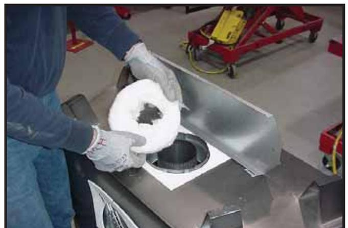
**Abbildung 9.6.** Entfernen Sie die Isolierung vom äußeren Abzugsrohr.
