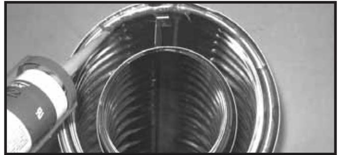
Abbildung 10.1 Dichtung aus temperaturbeständigem Silikon
