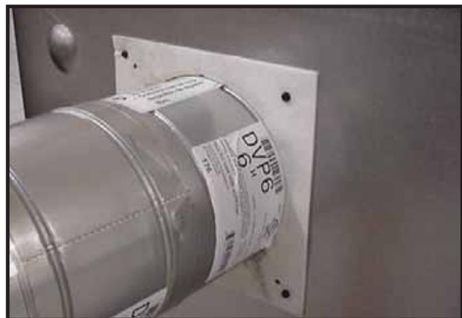
**Abbildung 9.12** Bringen Sie das erste Abzugssegment an (bis es einrastet). Schieben Sie die Isolierungsdichtung auf dem Abzugssegment über die Laschen auf das Gerät zu. Verwenden Sie zwei gewindeschneidende Schrauben, um die Dichtung an der Außenhülle zu befestigen.
