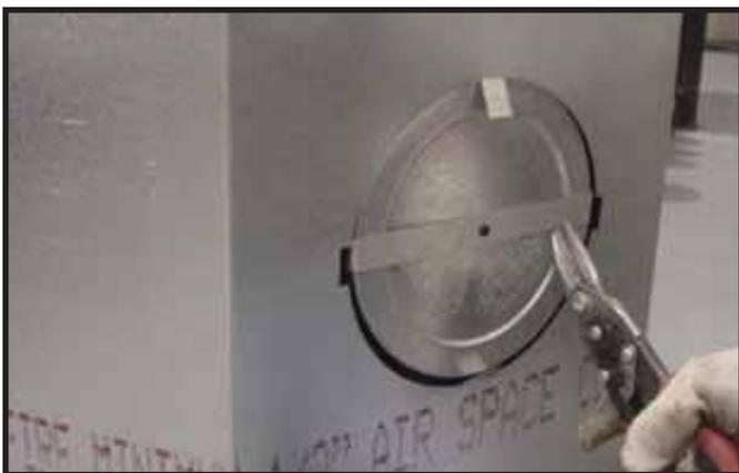
**Abbildung 9.9** Schneiden Sie den Haltestreifen aus Metall durch, und biegen Sie die Seiten nach außen.
