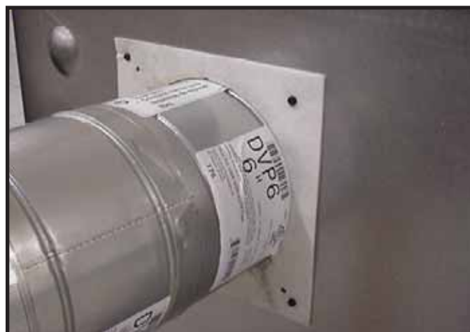
Figur 9.12 Fastgør den første del af udluftningsrøret (indtil det går i hak). Skub isoleringsproppen på udluftningsrøret op mod enheden og ud over taperne. Anvend to selvskærende skruer til at fastgøre pakningen til den udvendige beklædning.
