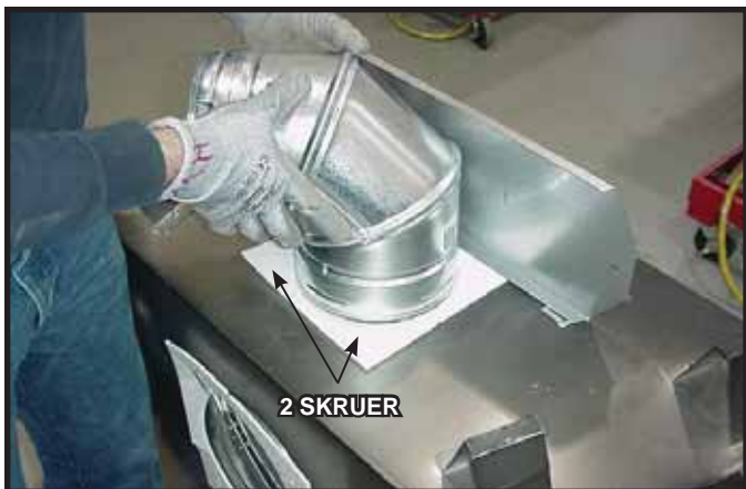
Figur 9.7 Når du fastgør den første del af udluftningsrøret, skal du sørge for at anvende glasfibertætningen til at forsegle samlingen mellem den første udluftningsdel og den udvendige varmeovnsbeklædning. Brug to selvskærende skruer til at fastgøre pakningen til den udvendige beklædning.
