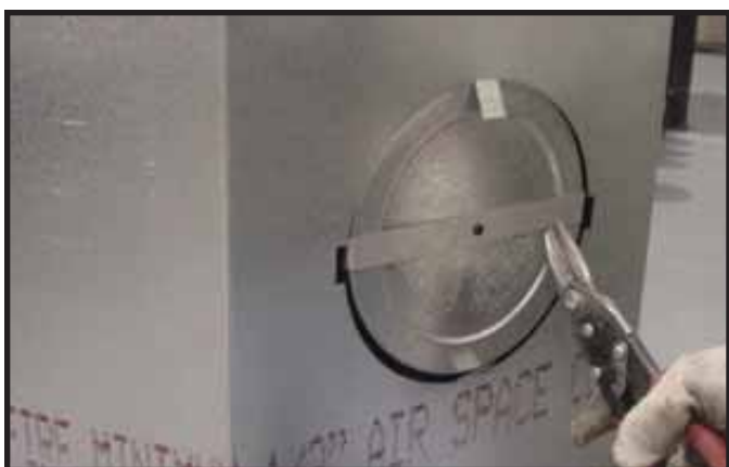
Figur 9.9 Skær metalbåndet over, og fold siderne udad.
