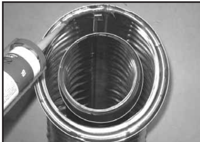
Figur 10.1 Forsegling med silikone til høje temperaturer
