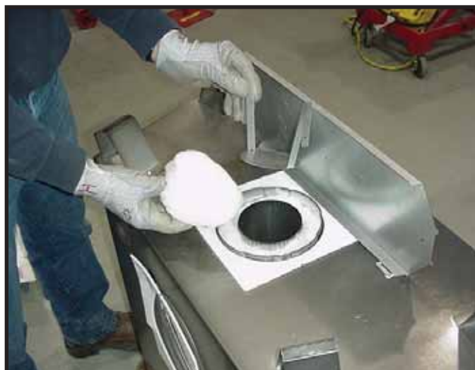
Figur 9.5 Fjern isoleringsproppen og det hvide isoleringsmateriale fra midten af ventilationsrøret.
