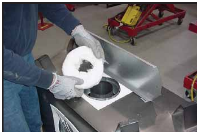
Figur 9.6 Fjern isoleringsmaterialet fra den ydre del af ventilationsrøret.
