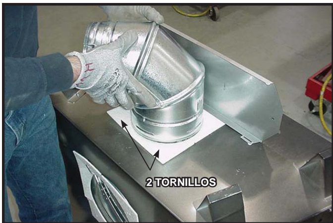
Figura 9.7 A la hora de instalar la primera sección del conducto, asegúrese de usar la empaquetadura de fibra de vidrio para sellar la abertura entre la primera sección de conducto y la chimenea. Utilice 2 tornillos autopercutores para sujetar la empaquetadura.
