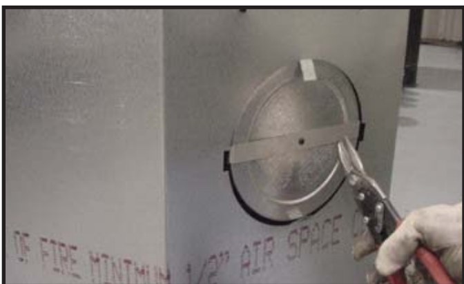
Figura 9.9 Corte la banda retenedora y dóblela hacia afuera.
