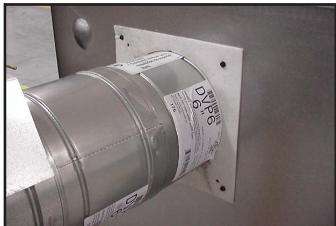
Figura 9.12 Una la primera sección de conducto a la chimenea. Coloque la empaquetadura alrededor del conducto y deslícela sobre las lengüetas hasta topar con la chimenea. Utilice 2 tornillos autopercutores para sujetar la empaquetadura.
