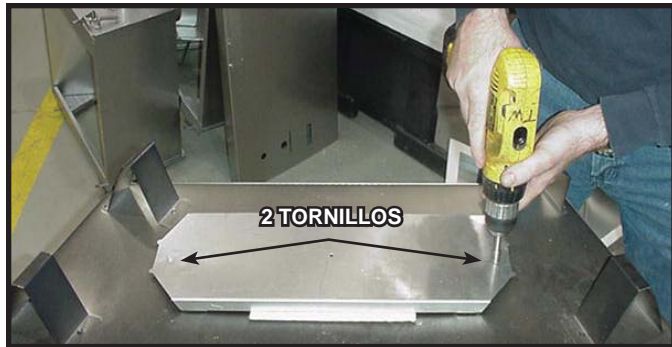
Figura 9.1 Para ventilar la chimenea por arriba, retire los dos tornillos que sujetan el escudo térmico superior. Para ventilar por atrás, consulte la sección 9.B.
