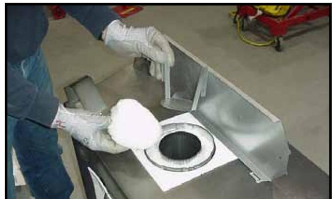
**Abbildung 20.** Entfernen Sie den Isolationskorb aus der Mitte des Abzugsrohrs.
