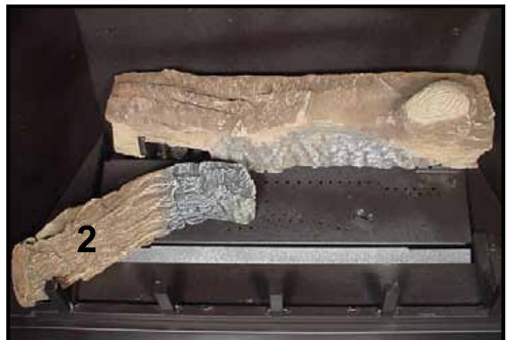
**Scheit Nr.2 (srv2033-701):** Platzieren Sie die untere Aussparung von Scheit 2 über den Roststab und richten Sie es über dem Brenner aus, indem Sie die Nut im Scheit wie gezeigt über die Brennerlasche positionieren.
