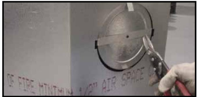
**Abbildung 24.** Schneiden Sie den Haltestreifen aus Metall durch, und biegen Sie die Seiten nach außen.
