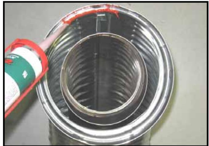
Abbildung 33. Dichtung aus temperaturbeständigem Silikon
