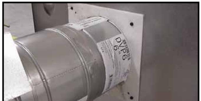
**Abbildung 27.** Bringen Sie das erste Abzugssegment an (bis es einrastet). Schieben Sie den Isolationskorb auf dem Abzugssegment über die Laschen auf das Gerät zu. Verwenden Sie 2 gewindeschneidende Schrauben, um die Dichtung an der Außenhülle zu befestigen.
