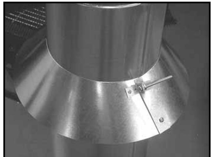
Abbildung 46. Anbringen des Windschutzes am Rohr
