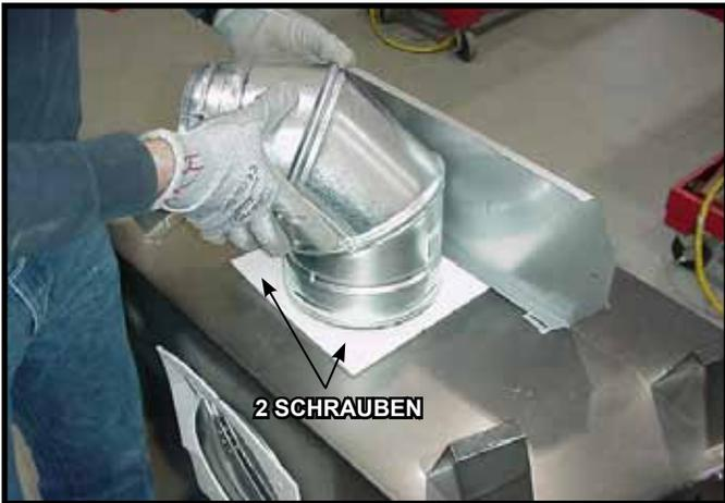
**Abbildung 22.** Um den ersten Abschnitt des Abzugsrohrs anzubringen, verwenden Sie die Fiberglasdichtung als Versiegelung zwischen der ersten Gaszugsrohrkomponente und der Kaminaußenhülle. Verwenden Sie 2 gewindeschneidende Schrauben, um die Dichtung an der Außenhülle zu befestigen.
