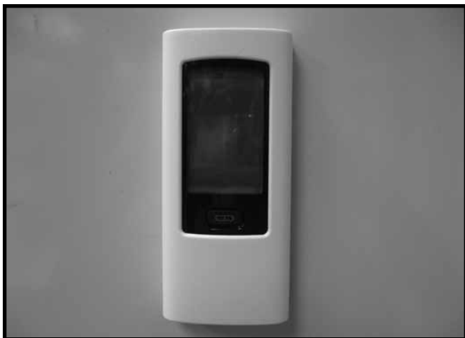
Obr. 12.8 Pripevnenie skrinky diaľkového ovládača
