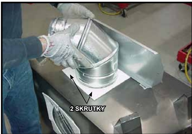
Obr. 9.7. Pri pripájaní prvého dielu rúry dymovodu nezabudnite použiť tesnenie zo sklenej vaty na utesnenie priestoru medzi prvým dielom dymovodu a vonkajším plášťom krbu. Na uchytenie tesnenia k vonkajšiemu plášťu použijete 2 samorezné skrutky.
