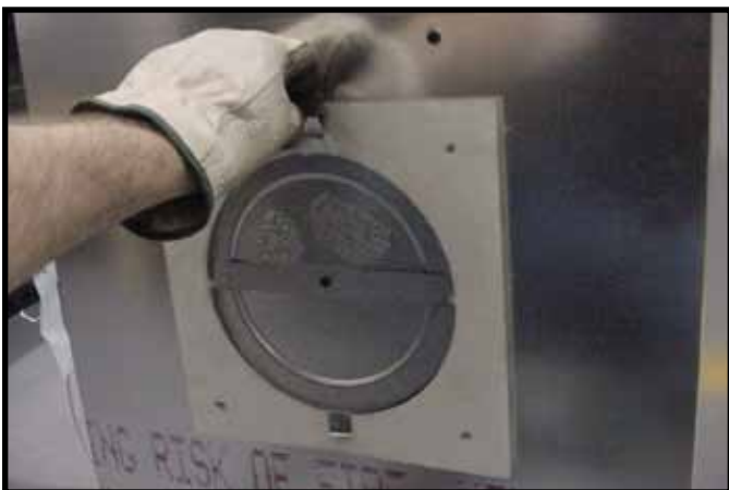
Obr. 9.8. Upevňovacie pliešky zahnite smerom do stredu protipožiarneho uzáveru (90°) a vyberte tesnenie.
