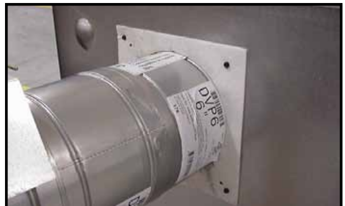
Figur 27. Fastgør den første del af skorstensrøret (indtil den går i hak). Skub isoleringspakningen på skorstensrøret op mod enheden og ud over tapperne. Anvend to selvskærende skruer til at fastgøre pakningen til den udvendige beklædning.
