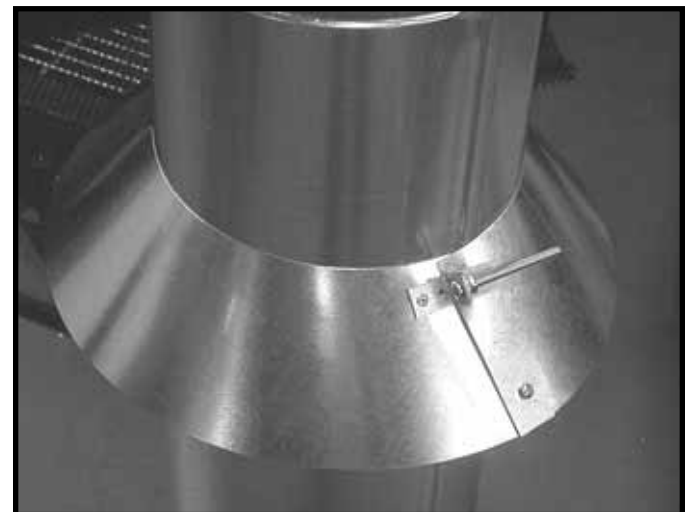
Figur 8.7 Samling af stormkraven omkring røret
