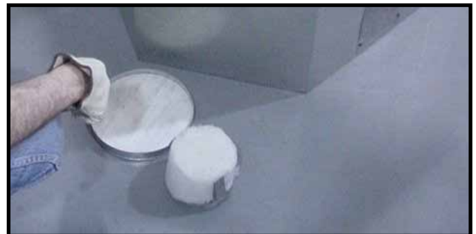
Figur 26. Kasser skorstensrørdækslet, fjern og kasser isoleringspakningen. Bemærk: Så snart skorstensrørdækslet er fjernet, kan det IKKE påmonteres igen.
