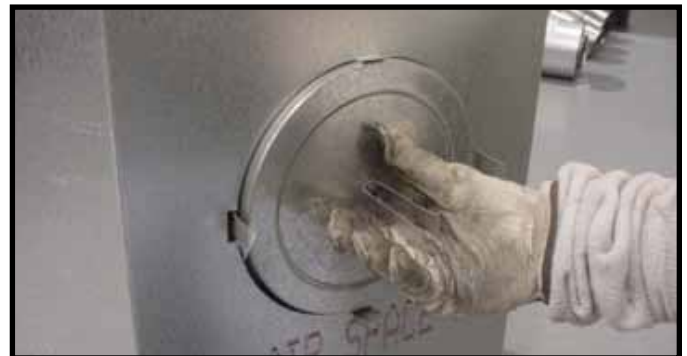
Figur 25. Fold den midterste del af båndet udad, så du kan fjerne skorstensrørets dæksel.
