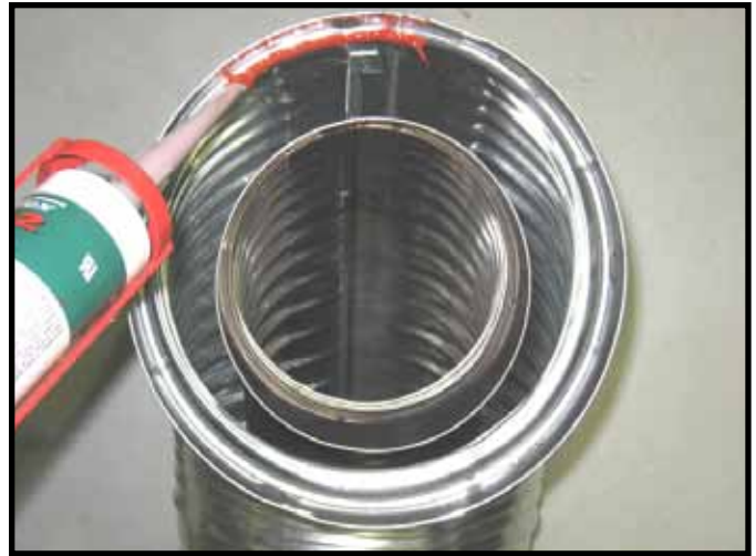
Figur 33. Forsegling med silikone til høje temperaturer
