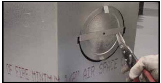
Figur 24. Skær metalbåndet over, og fold siderne udad.
